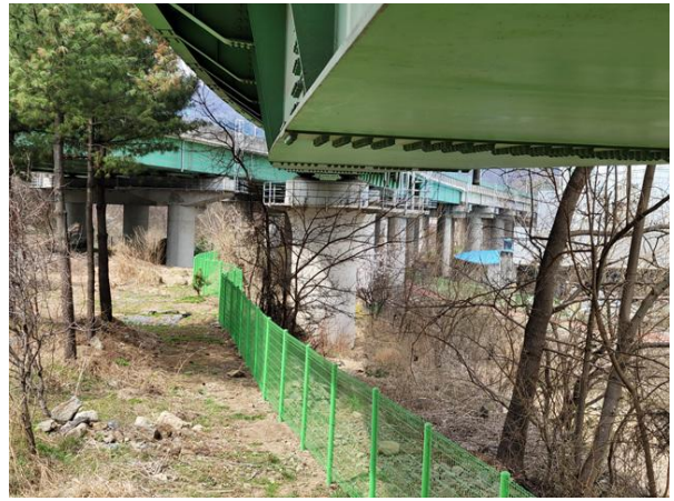
교각 P2 전경
