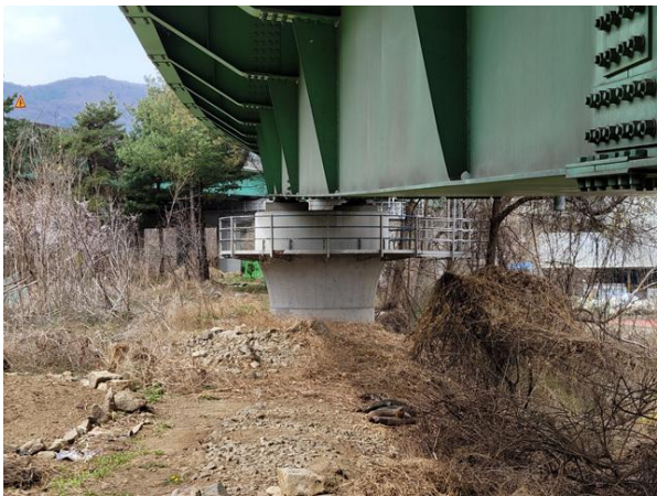
교각 P3 전경
