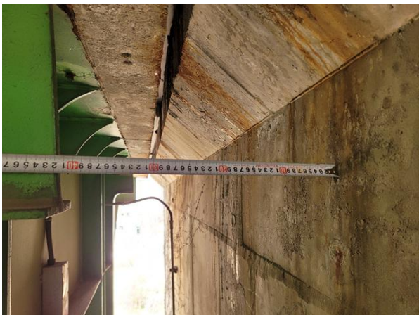
신축이음 하부 유간 측정 작업사진
