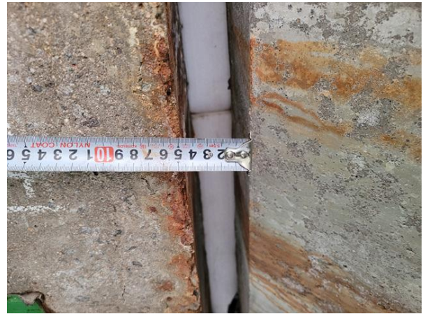
신축이음 하부 유간 측정 작업사진
