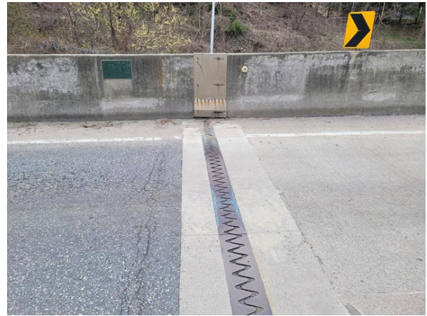
신축이음 A2 전경
