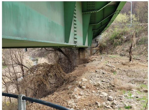
교대 A2 전경
